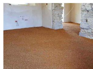
I GRANULATI CORK GRANULES SONO IDEALI PER LA REALIZZAZIONE DI MASSETTIA SECCO ISOLANTI ED ECOLOGICI, TRA IL SOLAIO ED IL MASSETTO
